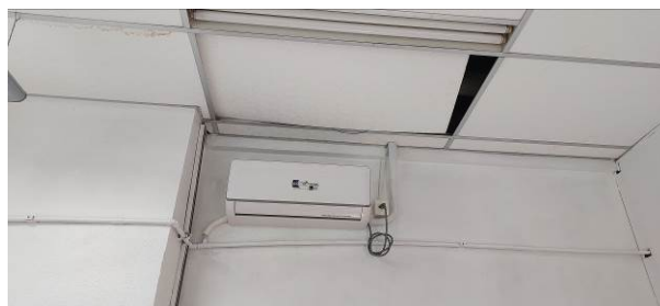
Foto 18: forro desencaixado
