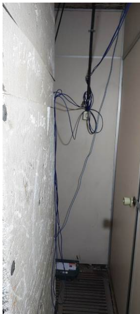
Foto 32: vista para norte
