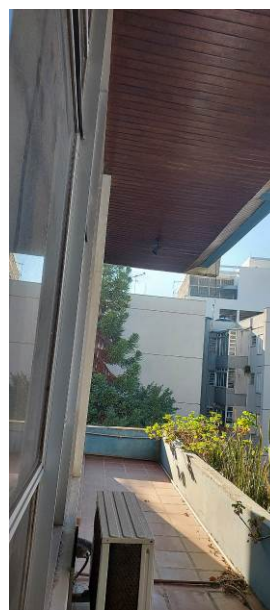
Foto 141: Fundos – vista para leste
