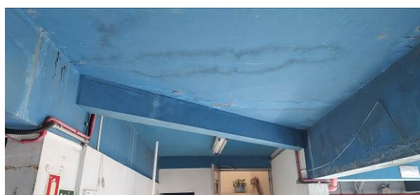
Foto 244: laje passarela frente
