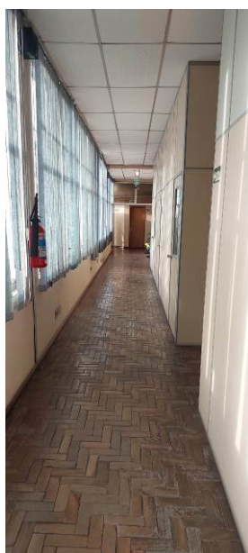
Foto 56: vista sul no intermediário
