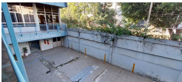
Foto 306: muro divisa leste
