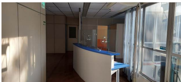
Foto 82: vista para norte
