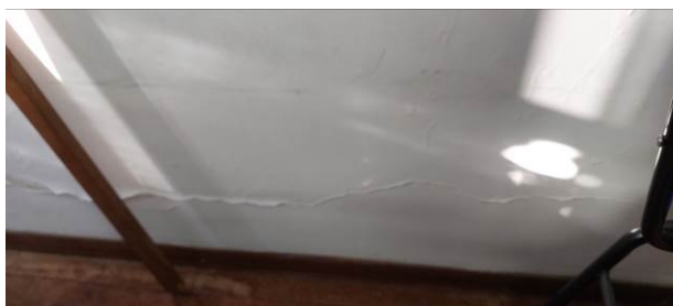
Foto 38: fissura horizontal
