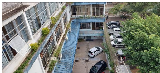
Foto 270: Passarela - vista para noroeste
