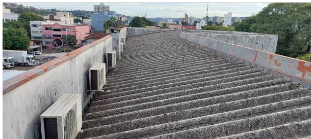
Foto 263: vista para norte
