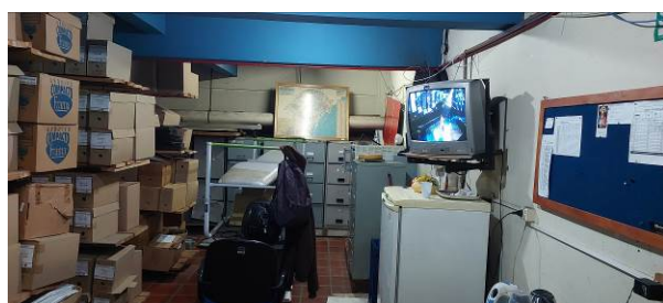
Foto 248: 2 - vista para oeste
