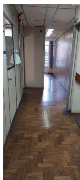
Foto 59: vista sul chegada escada
