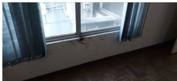
Foto 98: infiltrações janela sala 14
