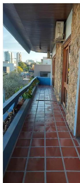
Foto 143: Frente – vista para oeste
