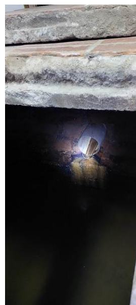
Foto 313: escoamento permanente
