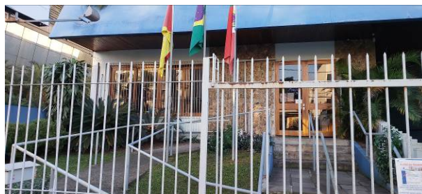
Foto 308: acesso principal ao Térreo
