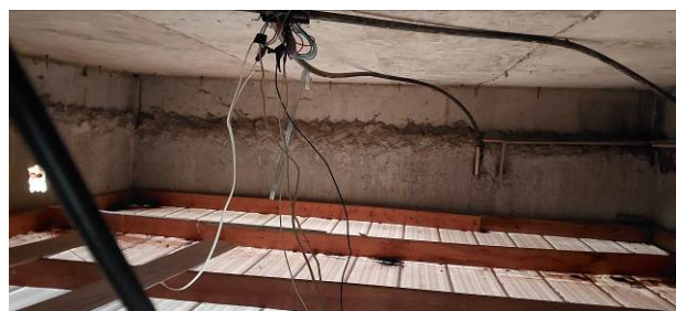
Foto 8: laje sobre forro para leste
