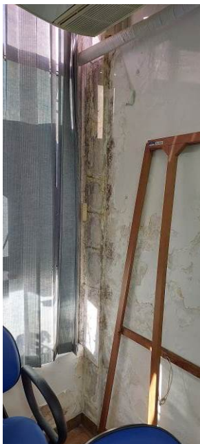
Foto 36: infiltrações na parede leste
