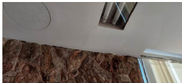
Foto 106: vista norte Foto 107: vista sudeste Foto 108: forro gesso com rachaduras
