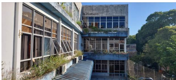
Foto 304: vista para norte
