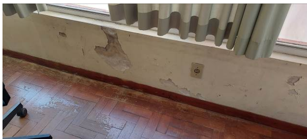
Foto 44: desagregamento e desgaste tacos
