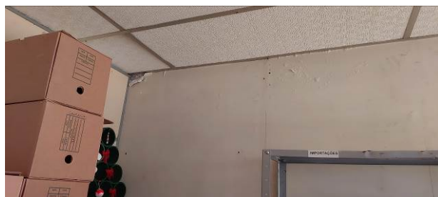
Foto 43: descascamento e bolhas
