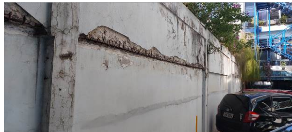
Foto 307: corrosão armaduras
