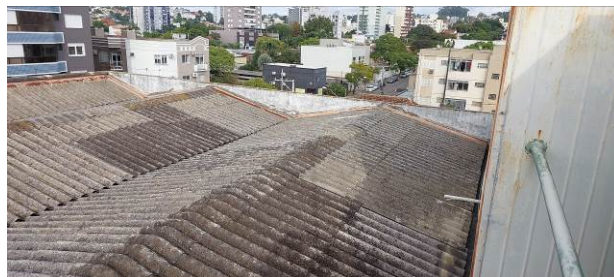
Foto 252: vista para oeste
