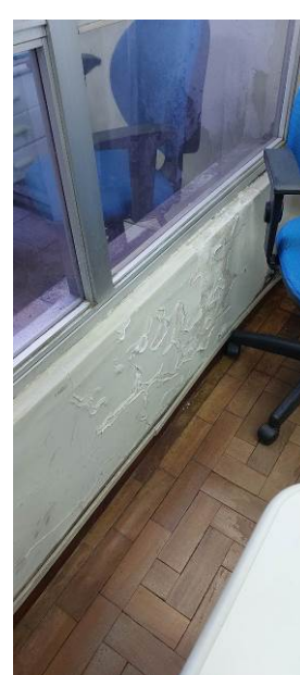
Foto 204: infiltração janela
