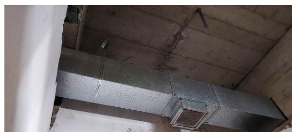
Foto 26: forro – parte depósito
