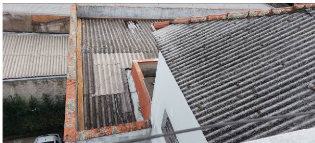
Foto 265: vista para norte
